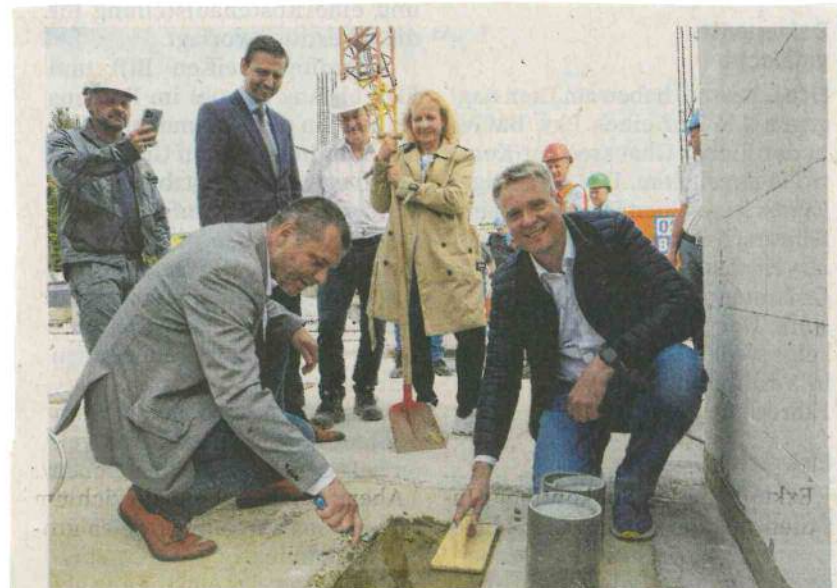
Erledigt: Amtsdirektor André Nedlin, Barnims Bildungs-Dezernent Oliver Turner, Schulleiterin Cornelia Grasse und Bürgermeister Carsten Bruch haben den Grundstein gelegt. Foto: Sergej Scheibe
